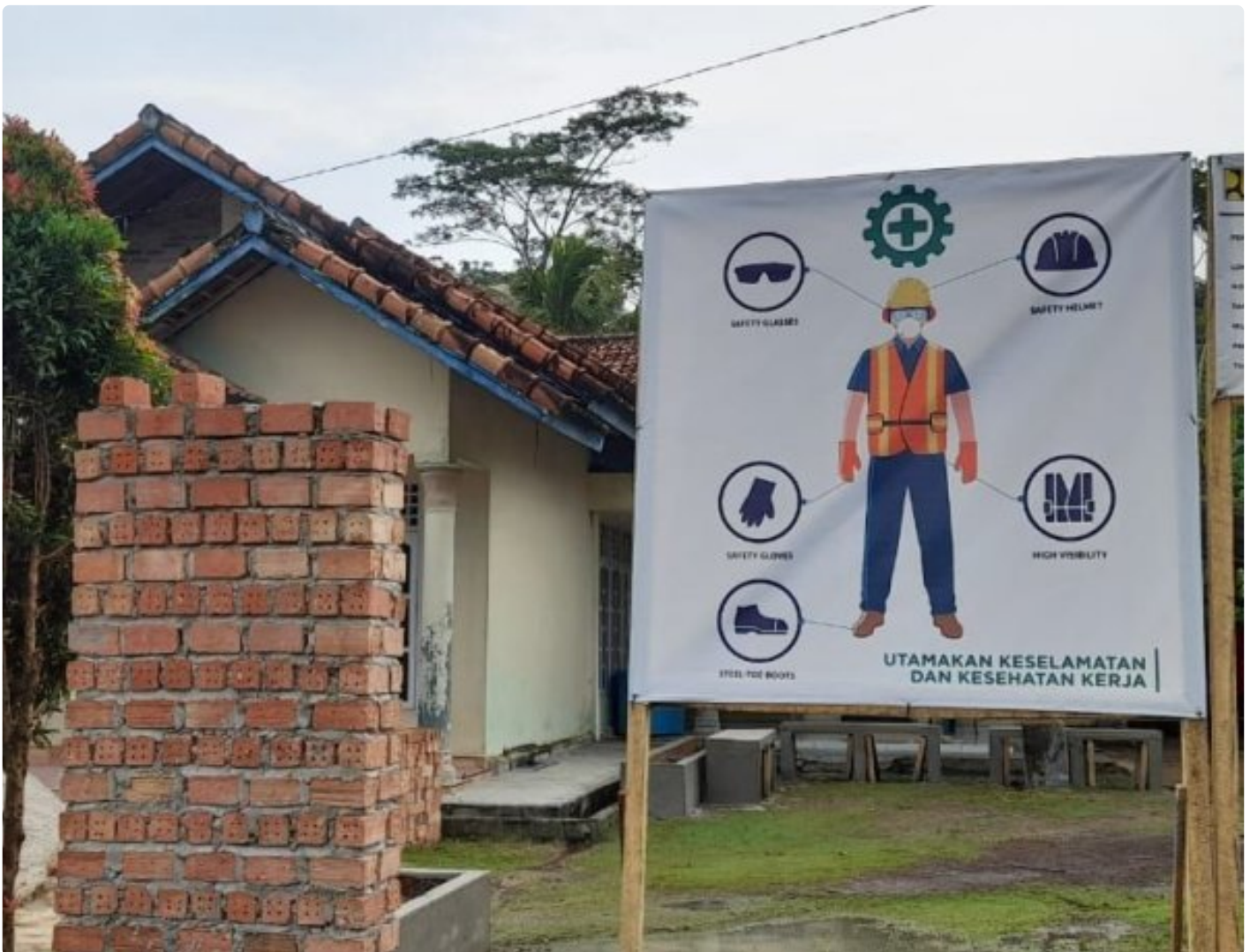
Proyek Infrastruktur Hunian Hijau di Mesuji
